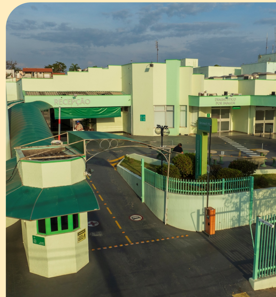
Hospital e Maternidade Unimed em São João da Boa Vista
