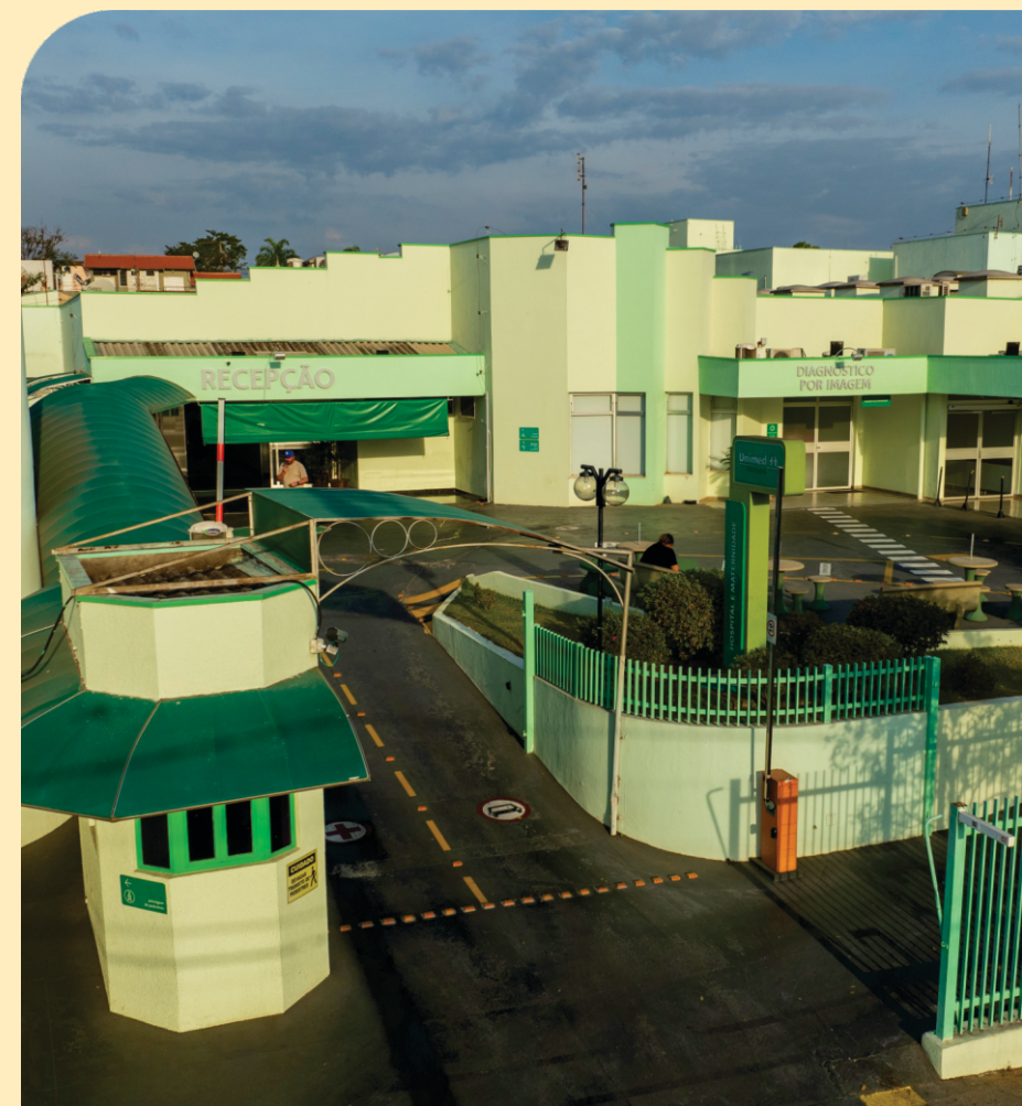
Hospital e Maternidade Unimed em São João da Boa Vista
